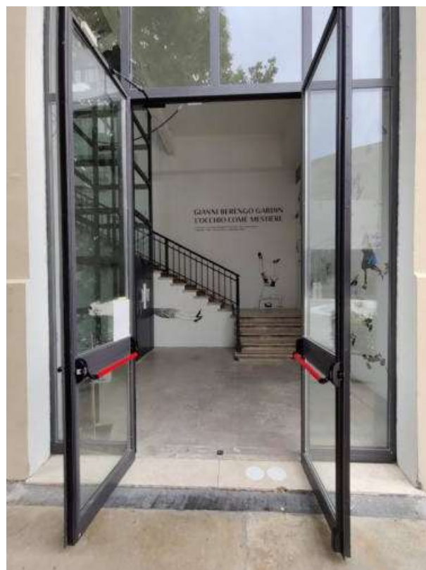
Ingresso Edificio D: stato dei luoghi
