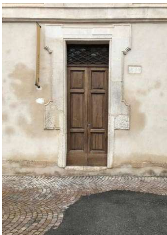
2. Ingresso laterale: stato dei luoghi
